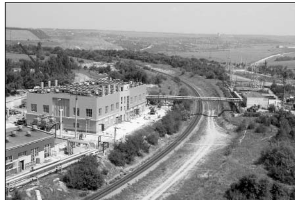
Рис. 3. Общий вид площадки строительства
