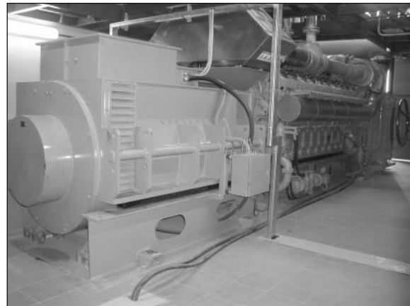
Рис. 2. Фото общего вида когенерационного модуля JMS620
