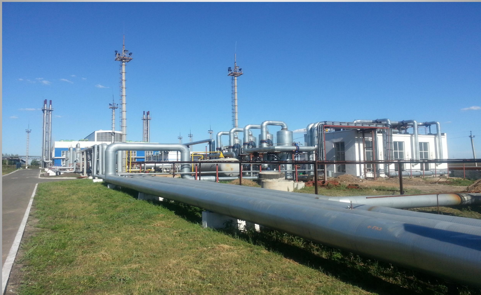
Шахта «Покровская», 75 МВт el (запущено 18 МВт el )
